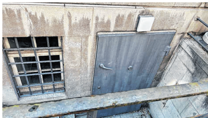
Eine Eisentür führt am Ebertplatz zu einem Keller – eine der wenigen noch erhaltenen massiven Luftschutztüren.
